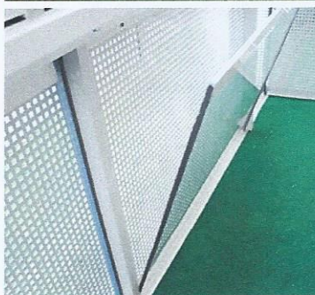
Öppningsbart glas mot räcket
